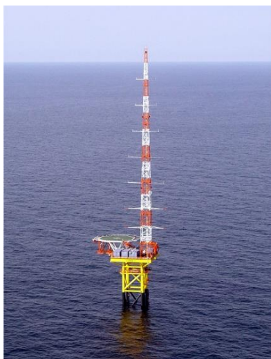
תמונה 2: מתקן המחקר FINO1 שבים הצפוני. מתקן תורן בגובה של כ- 100 מ'.
