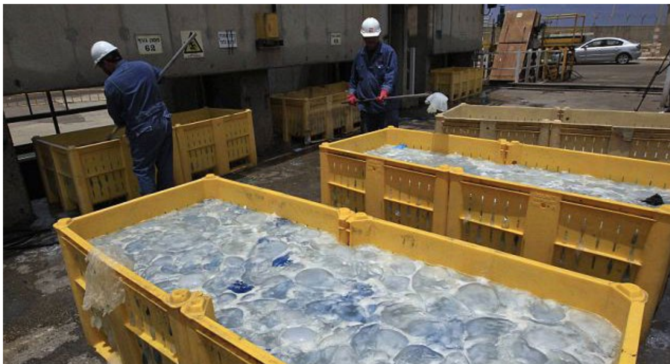
פינוי מדוזות ממסנני משאבות מי קירור של חברת החשמל | צילומים באדיבות חברת החשמל לישראל.
